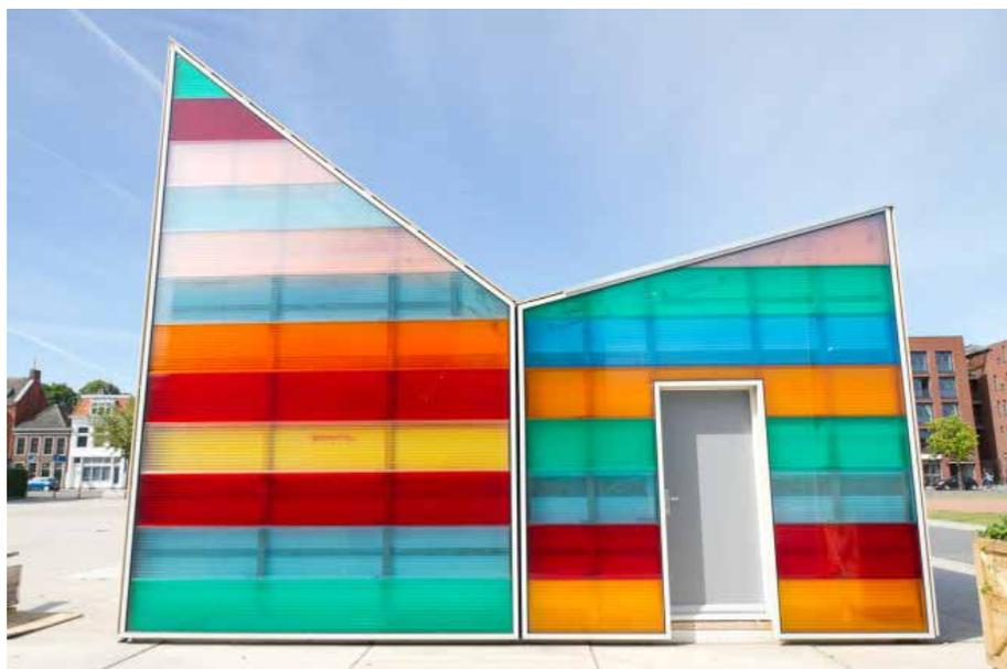
Il Lighthouse è un edificio costruito principalmente con blocchi di schiuma EPS, legno e pannelli colorati in policarbonato. Questa particolare configurazione permette uno sfruttamento intensivo dell'energia solare (grazie al policarbonato) e allo stesso tempo insonorizza il locale (grazie all'aria
